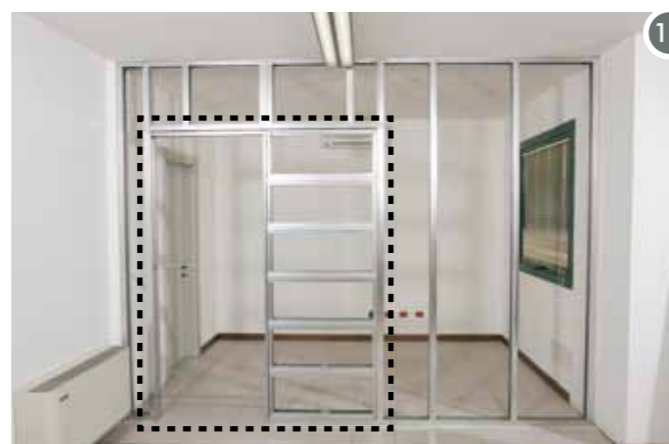
Фаза 18 Закрепить вертикальные стойки (f) и (c) к металлическому каркасу проема (Саморезы в комплект не входят). Внимание: листы гипсокартона крепить к пеналу исключительно на саморезы 3,5x19 (в комплекте). Если крепить другими саморезами, то ECLISSE снимает с себя всюкую ответственность в случае порчи полотна.
